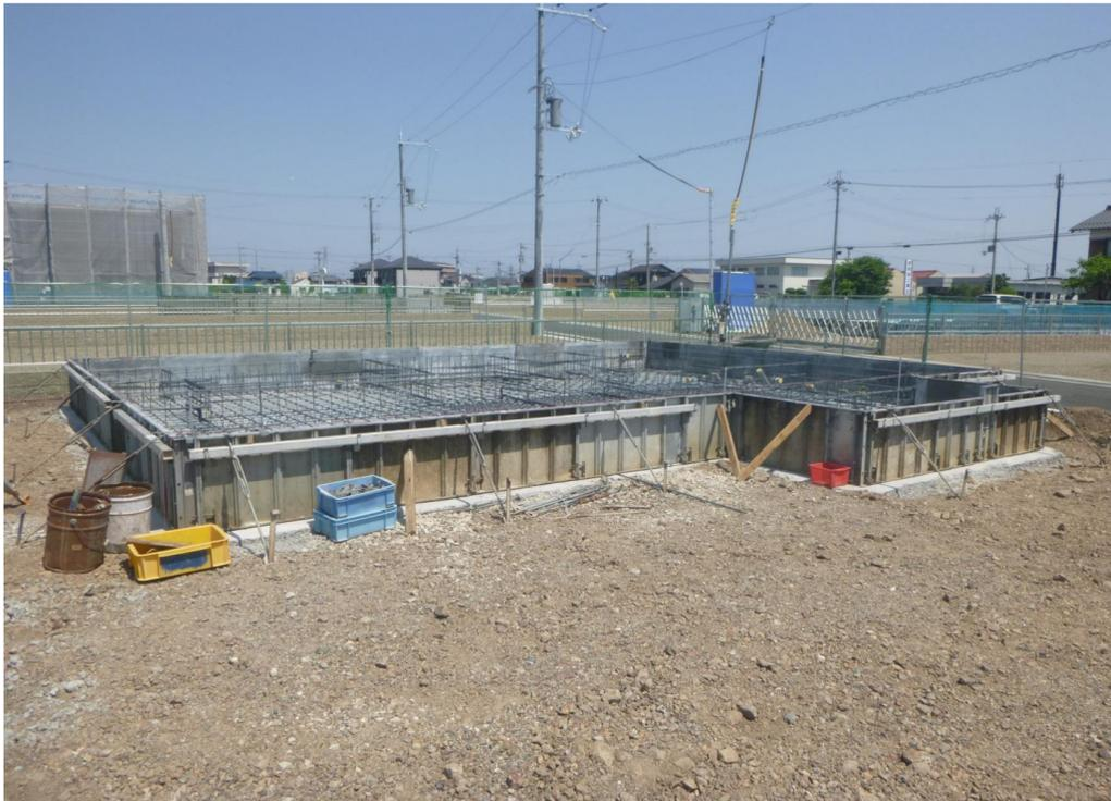
基礎鉄筋施工状況
